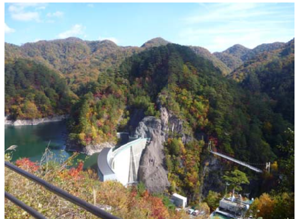
川俣ダム天端
