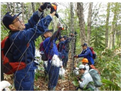
シカ柵設置中
