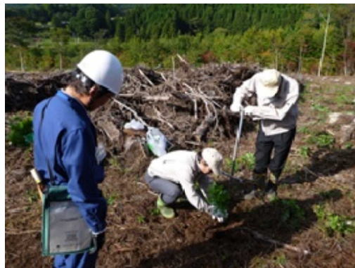
市町村長によるコンテナ苗の植樹体験
