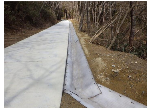
▲銅山林道外1改良工事（R2三次補正）
