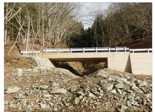
▲入山林道改良工事（R2ゼロ国）
