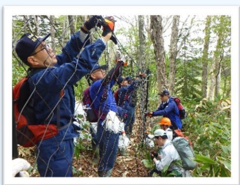
シカ柵設置中
