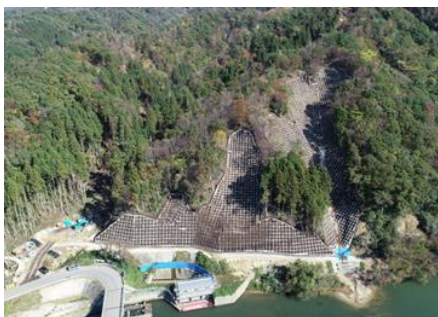
集中豪雨による被害箇所への復旧状況（新潟県村上市）
