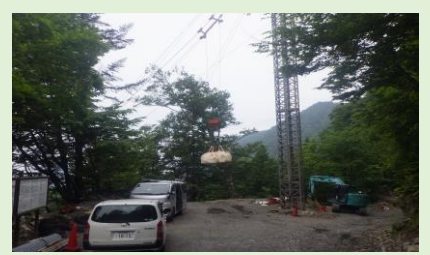
資器材を運搬するケーブルクレーン
