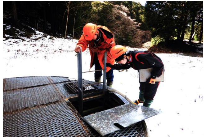
地すべり防止工事（集水井）の見学
