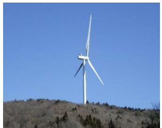
風車発電施設
