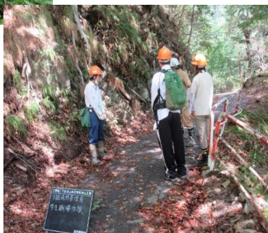
治山工事の監督業務
