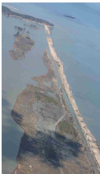
▲ 松川浦地区の被災状況
