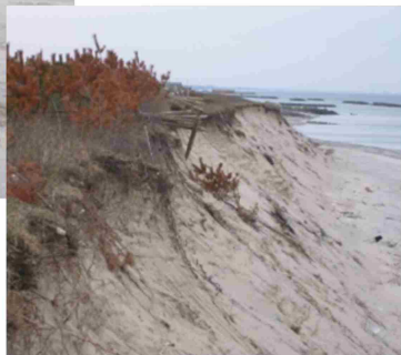
▲ 防風柵工の破損状況
