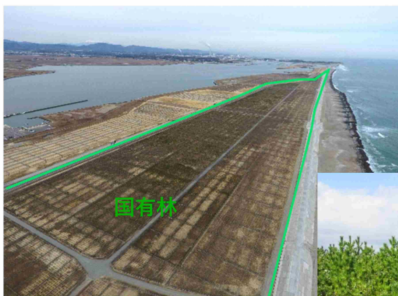
▲ 松川浦地区の復旧状況 (令和2年6月)
