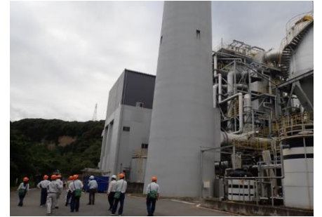
木質バイオマス発電施設
