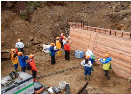
治山えん堤の工事現場
