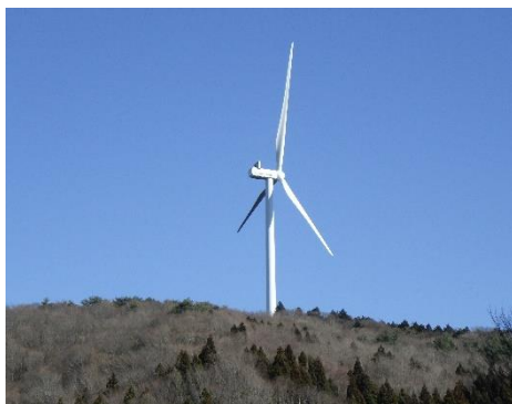
風車発電施設
