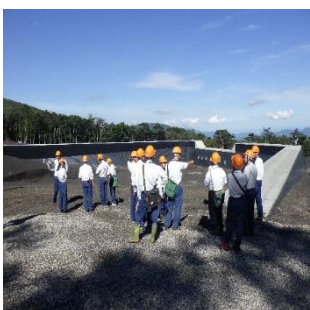
治山ダム工の現地視察（大日沢地内）
