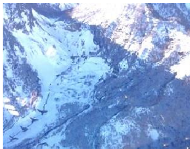
【妙高市大字関山地内（国有林）】 治山施設等の被害は確認されず
