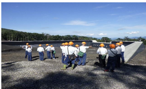
治山ダム工の現地視察（大日沢地内）
