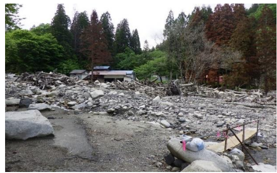
弥生集落の被災状況
