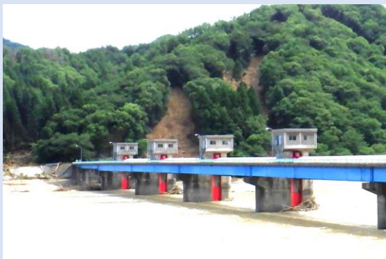
山腹崩壊箇所（遠景）
