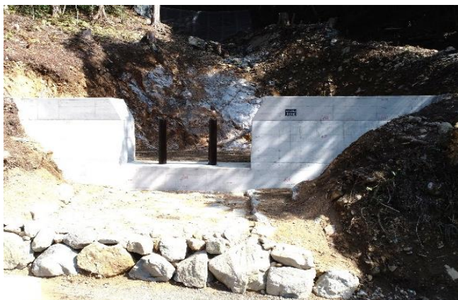
渓間工（流木防止対策） （伊豆森林管理署管内）
