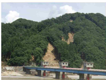
被災状況 (村上市薬師岳地区)
