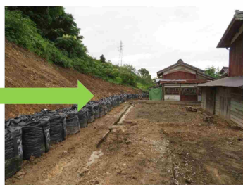
応急復旧完了 (土砂撤去・大型土のう)
