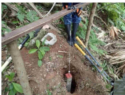
▲ 境界標の埋設作業
