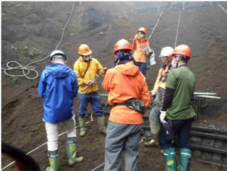
▲ スコリア地質での施工上の工夫の説明
