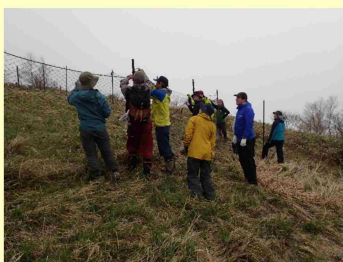
▲ 2022年5月 (三国峠での防シカ防護柵設置作業)
