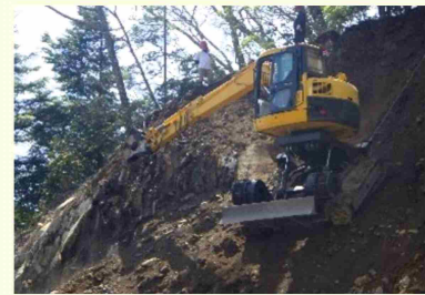
RCMによる法面整形
