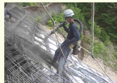
簡易法枠工の施工
