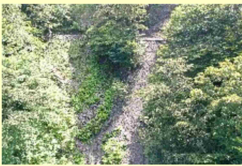
▲ 信濃俣地区の治山工事着手前
