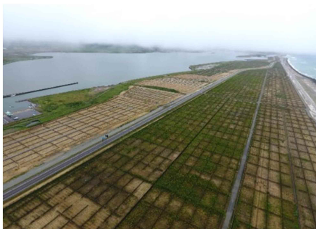
海岸防災林復旧の状況
