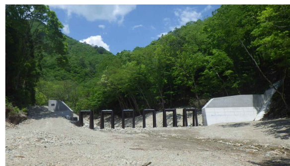
【H31完成:鋼製スリット谷止工(日光署)】
