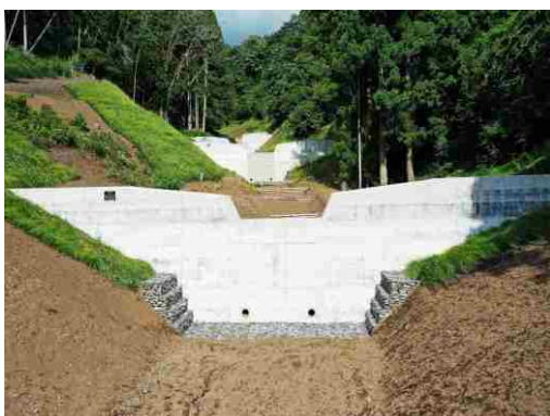
▲小山地区（奥の沢川 1 外）直轄治山工事（R2 三次補正）
