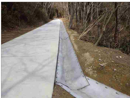
▲銅山林道外1改良工事（R2 三次補正）
