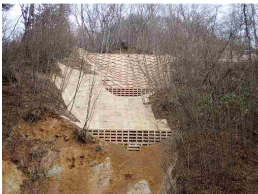
▲相倉地区復旧治山工事
