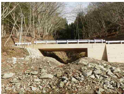
▲入山林道改良工事（R2ゼロ国）
