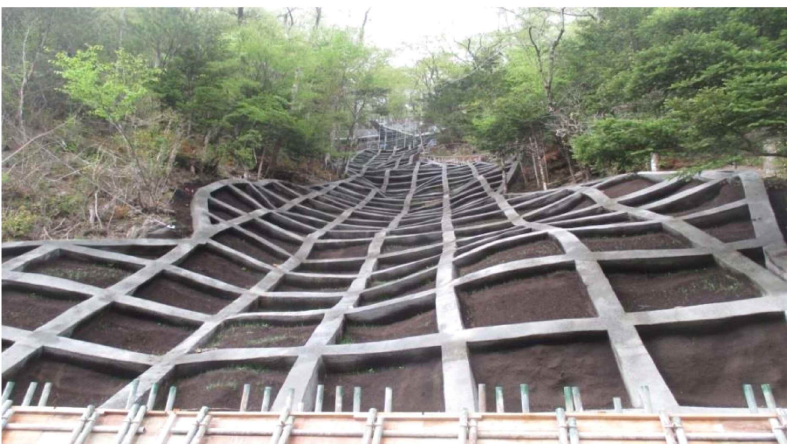
山腹工（のり枠工）施工中
