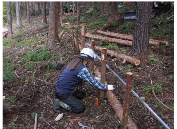
丸太筋工施工中
