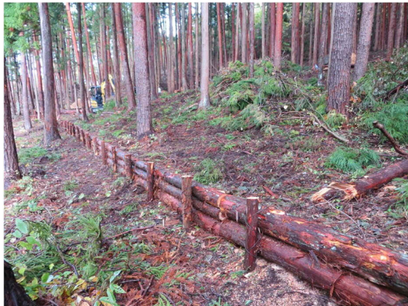
丸太筋工施工後
