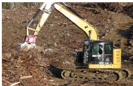
伐採と平行した枝条の片付け
