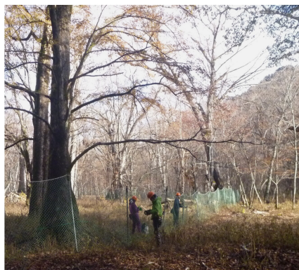
シカ柵修繕作業
