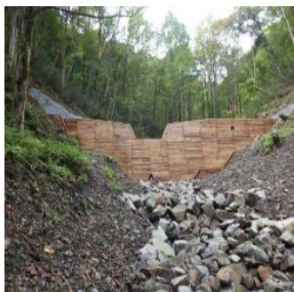
木製残存型杭を使用した コンクリート谷止工
