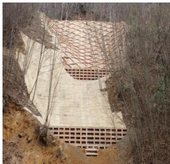
木材を使用したかご杭工と 法杭工
