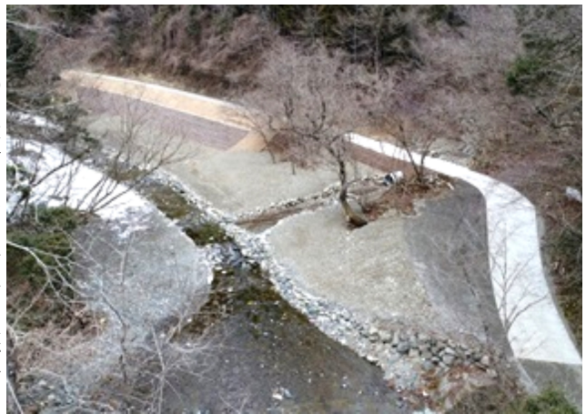
法行沢林道改良工事（H28二次補正）
