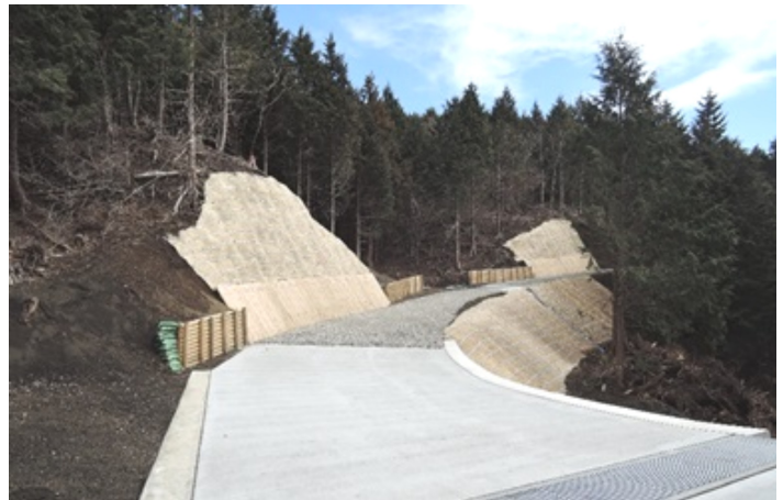
大洞第二支線林業専用道新設外工事
