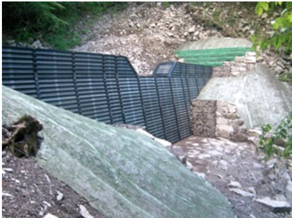
深沢復旧治山工事（H28二次補正）
