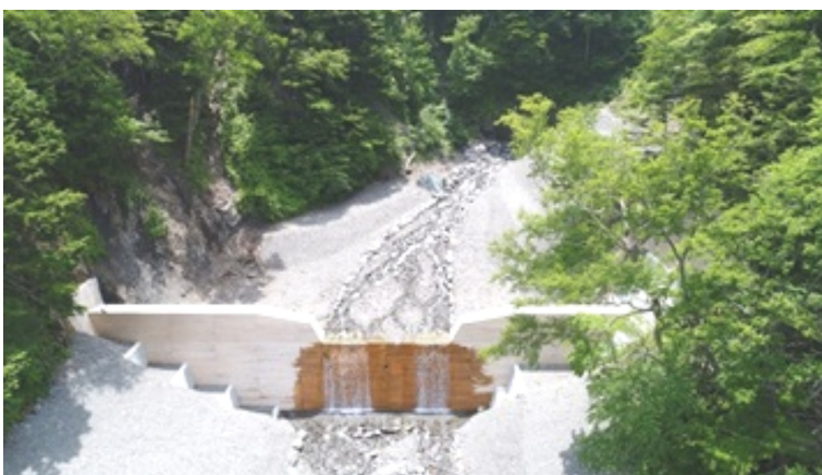
野呂川小樺沢復旧治山工事
