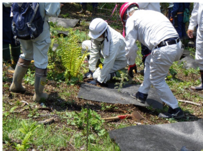
▲ 植生等を除去後に防草シートを敷設
