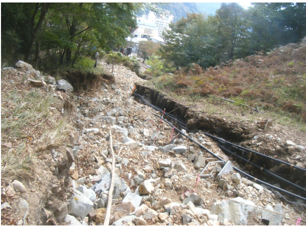
豪雨による被災の状況（栃木県日光市）
