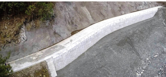
水の木幹線林道（復旧の状況）
