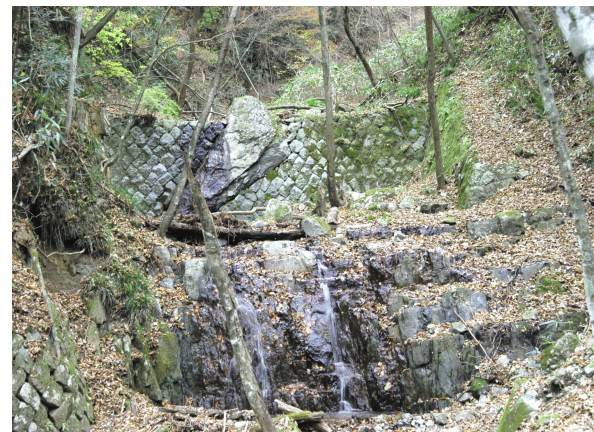
(写真2) 天然の大岩を巻き込んだ、石積の土留工
