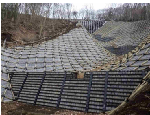
▲ 山腹工（土留工・法枠工）
