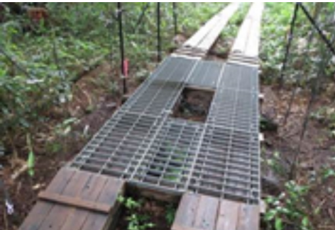
木道上のグレーチング設置
