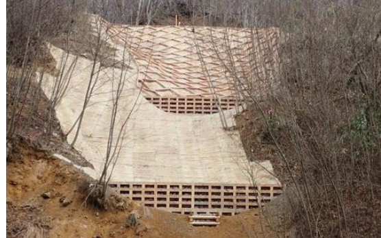
木材を使用したかご枠工と法枠工
