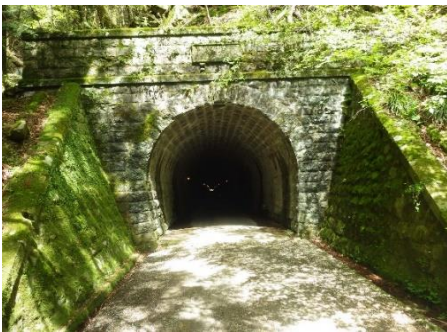
きゅうあまぎやまづいどう 旧天城山隧道
