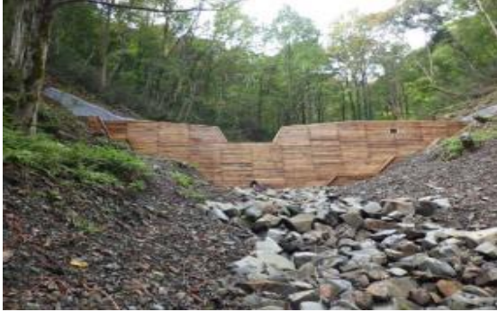
木製残存型枠を使用したコンクリート谷止工
