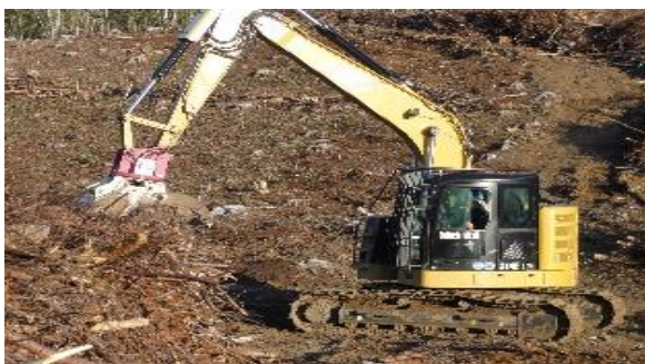
伐採と併行した枝条の片付け作業（地拵え）
