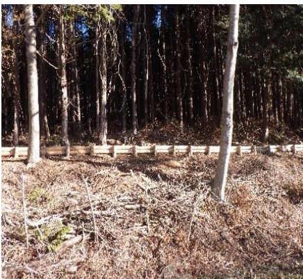
福島県飯館村における森林整備 (除伐作業と丸太筋工)
