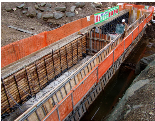
丸太や県産材合板を使用した型枠
