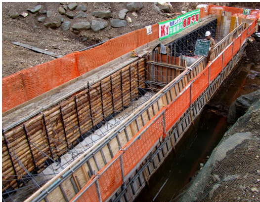
丸太や県産材合板を使用した型枠
