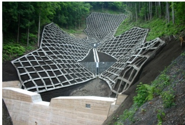
山腹崩壊地の復旧（溪間工、山腹工）
