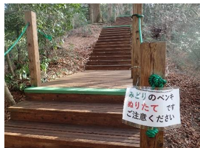
▲ 作業後の状況
