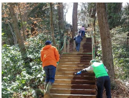
▲ 作業中の状況
