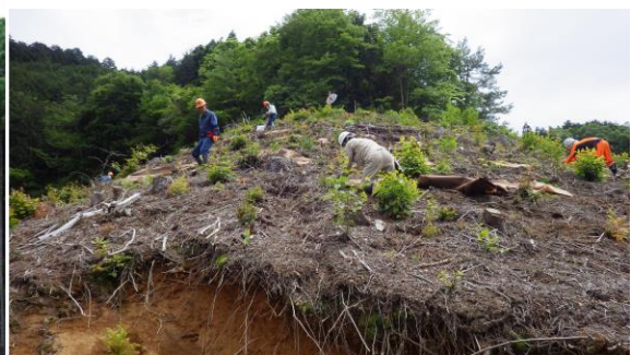
防草シートの施工風景
