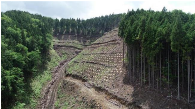
防草シートの施工箇所
