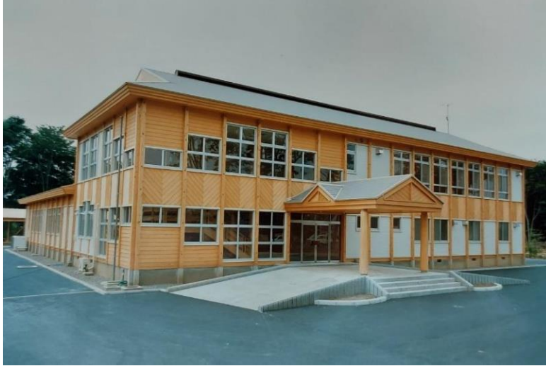
写真2 平成2年（1990年）完成したばかりの新庁舎
