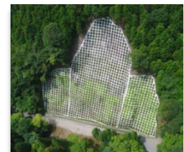
田沢地区(黒檜山東麓)(桐生市) (山腹工で崩壊した山の斜面の侵食や拡大崩壊を防いでいます。)
