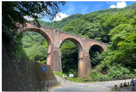
碓氷第三橋梁(めがね橋)(安中市) (明治25(1892)年完成の煉瓦造りの橋梁(国重要文化財))
