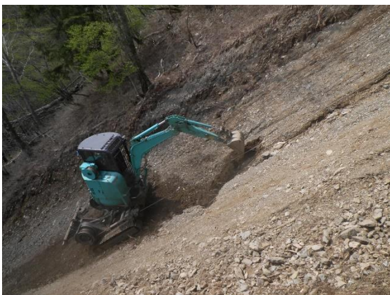
ロック・クライミング・マシンによる法切作業
