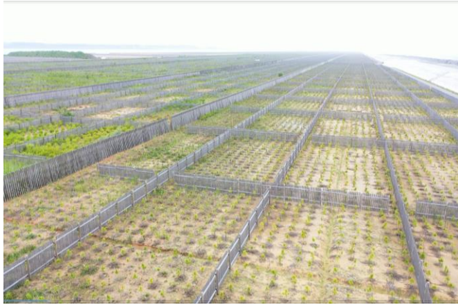
松川浦地区海岸防災林
