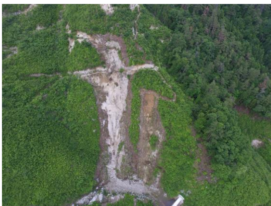
山腹工施工前
