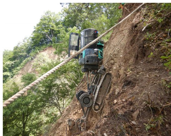
【ロッククライミング工法の山腹工（会津若松市）】
