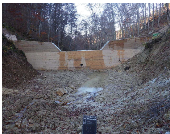
【大雨災害の復旧治山（金山町）】
