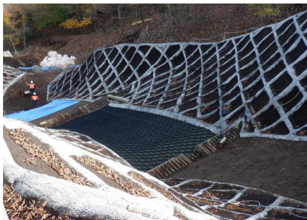
世附地域でのスコリア土壌に対応した工事
