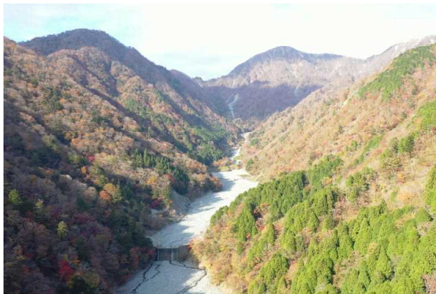
蛭ヶ岳（奥）と玄倉川（熊木沢）の谷止工
