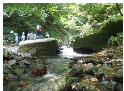
茂倉沢No.3 治山ダム
