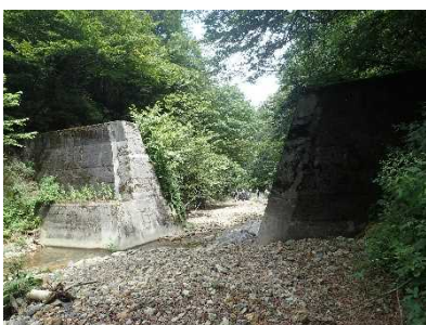
茂倉沢2号治山ダム 2009年11月に中央部を撤去
