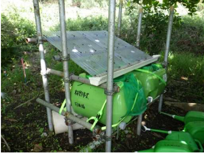
兄島の雨水タンク
