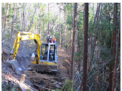
森林作業道作設
