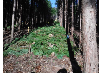
編柵工（施工後）
