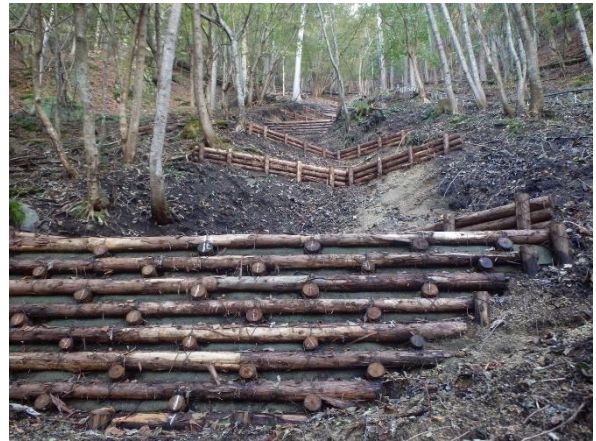
写真1 令和元年度施工の山腹工
